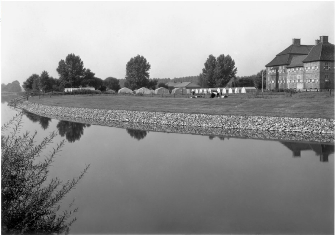
Anfang September 1969 ist das Ufer abgeschrägt und mit Schüttsteinen befestigt.
