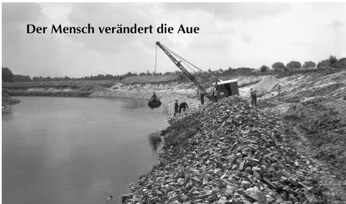
Ein Bild aus den 1960er Jahren: Ein Bautrupps des Lippeverbandes sichert einen Prallhang.
