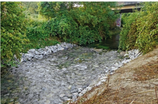
Seit Herstellung einer Rauhen Gleite im August 2014 können hier auch die Groppen wieder bachaufwärts wandern.
