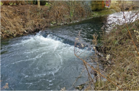
Diese Sohlschwelle im Soestbach im Bereich der Borgeler Mühle war für die sich am Boden bewegenden Groppen unüberwindbar.
