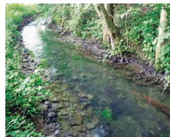
Bachabschnitt mit Uferbefestigung
