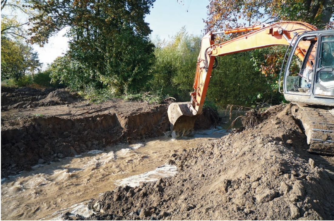
Eine neu angelegte Laufverlängerung wird an die Ahse angeschlossen.
