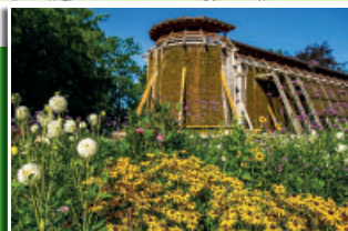
Gradierwerk im Kurpark
